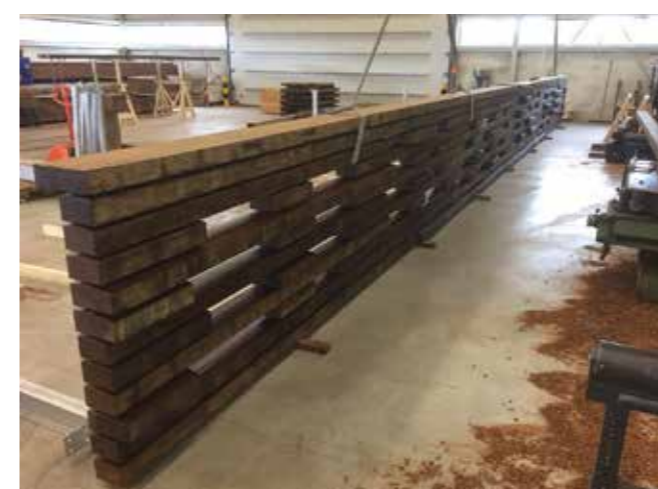
Circulaire brug in opbouw Bron: Meerdink bruggen.
