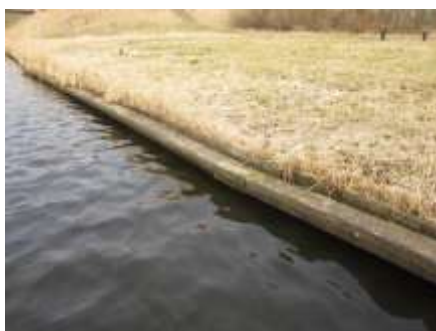
Foto 2. Verankerde damwand van voor 1986 (Bron: Van Heerde, 2013)
