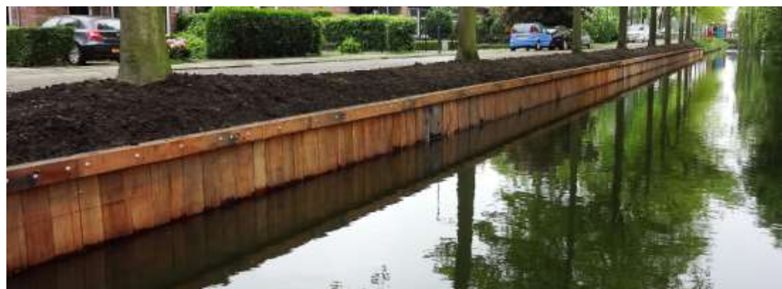
Foto 1: Azobé damwand met gording te Breukelen (Bron: WABenecke.nl)
