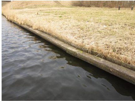
Foto 2. Verankerde damwand van voor 1986 (Bron: Van Heerde, 2013)
