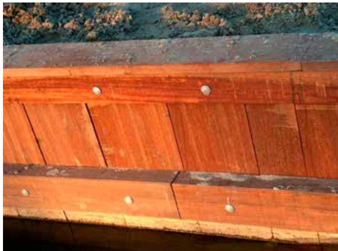
Figuur 10. Damwandconstructie met deksloof.
