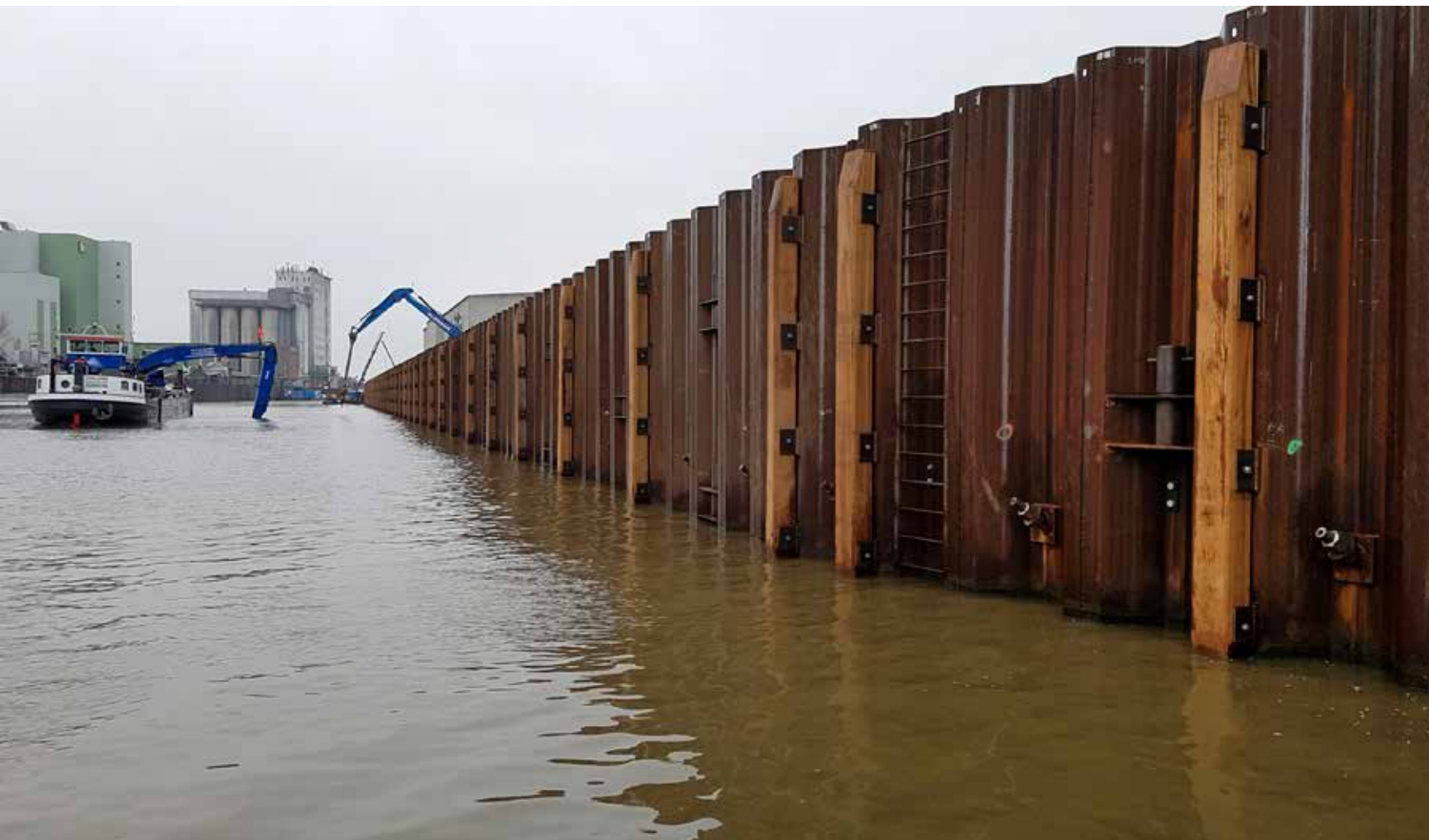
Om de boten te beschermen tegen het harde materiaal van de nieuwe oeverconstructie, zijn wrijfgordingen aangebracht.
