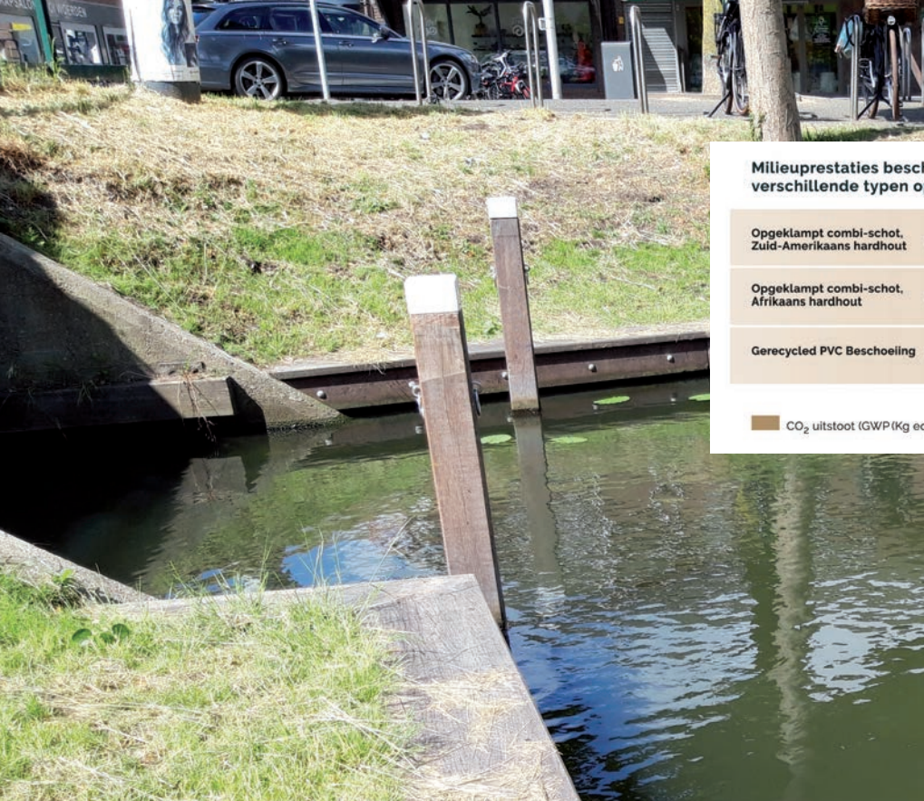
Damwand met houten deksloof gaat aanzienlijk langer mee - Bron Wijma Kampen
