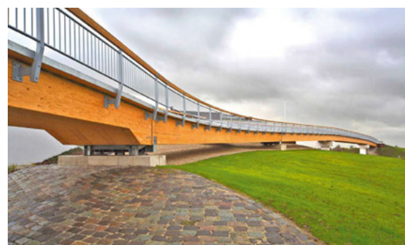
Brug Marnemoende te IJsselstein overspant met 34 meter de Hollandse IJssel
