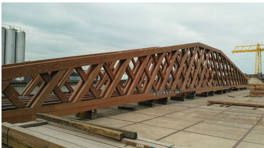
Hoofddraagconstructie Pieter Smitbrug | Foto: Wijma Kampen BV
