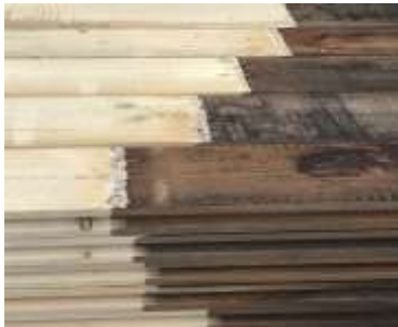
Figuur 2. Combidamwand van naaldhout met gerecycled Azobé op de waterlijn. Bron: W.A.Benecke/VanSwaay
