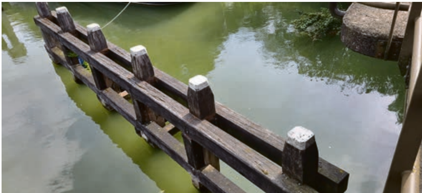
Houten remmingwerk van duurzaam gecertificeerd tropisch hout.
